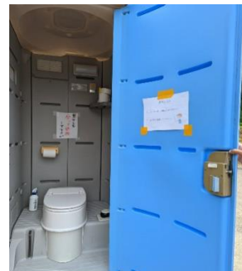
仮設トイレ 足で踏まないと水が流れない 説明ポスター貼付
