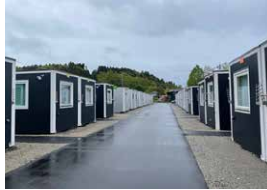
舗装が完了した仮設住宅
