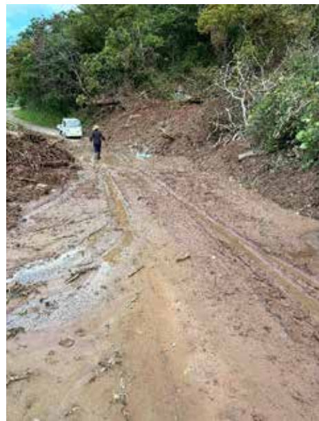
短時間の降雨で土砂が流出・堆積した道路
