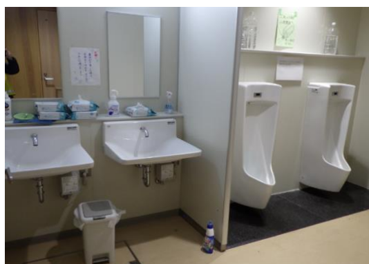
男子トイレに設置した排水用の水など
