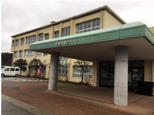
珠洲市立健民体育館
