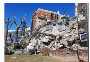
崩壊した建物
