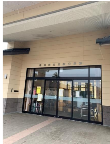
正院公民館避難所入口
